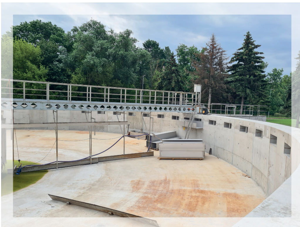
Usazovací nádrž – ČOV Hodonín po sanaci
