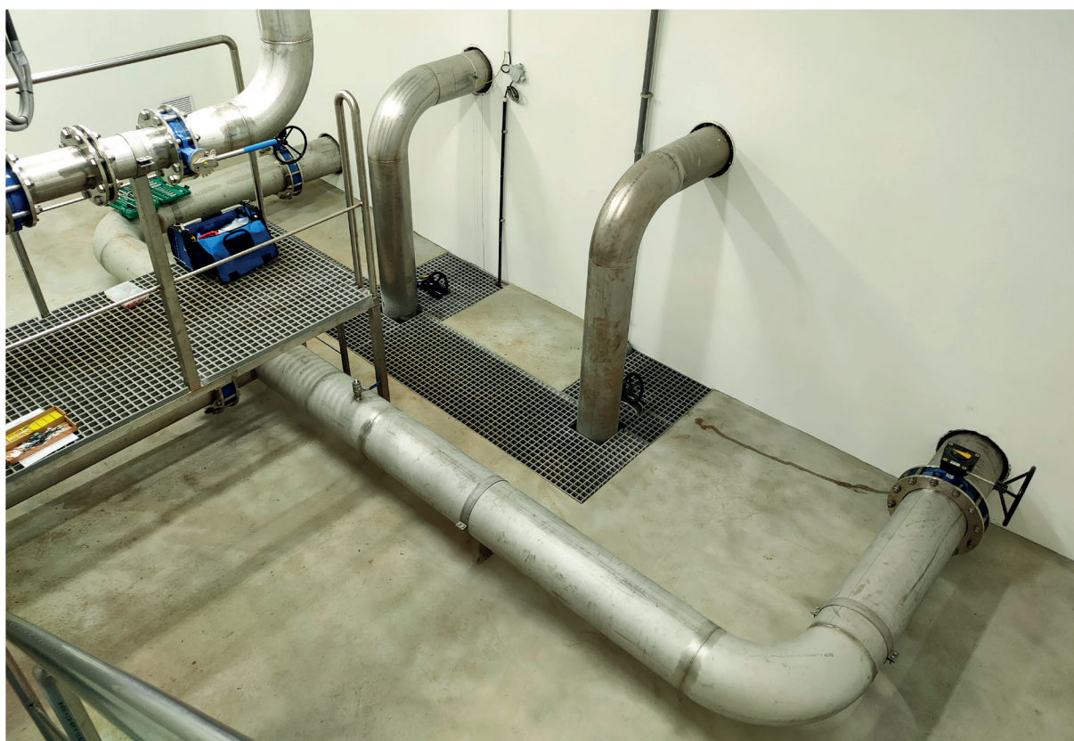
VDJ Pánov - výměna potrubí
