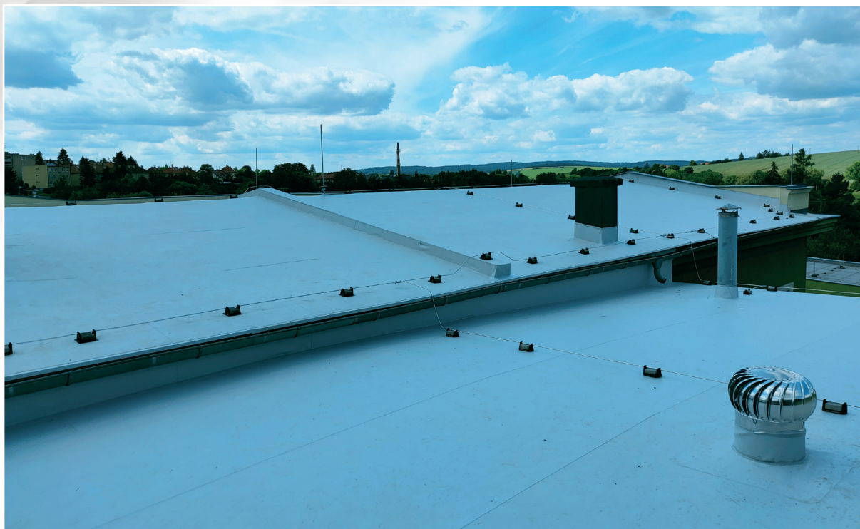
ÚV Koryčany - oprava střechy
