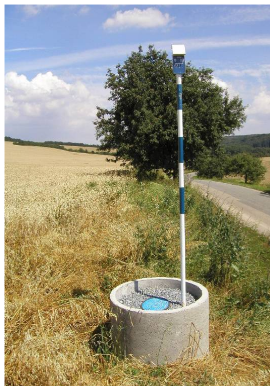
Úprava vzdušníku na terénu
