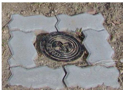
Obdláždění ventilového poklopu
