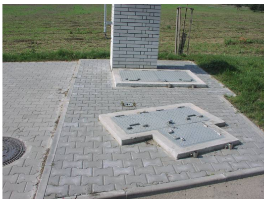
Úprava povrchu kolem šachty
