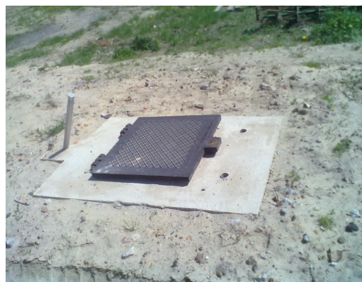
Úprava povrchu kolem šachty
