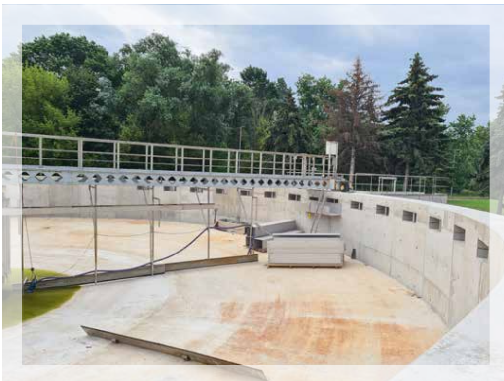
Usazovací nádrž – ČOV Hodonín po sanaci
