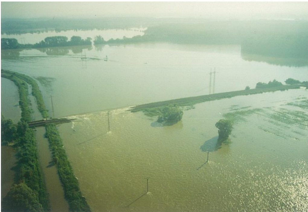
Obr.4a Železniční koridor z Bzence do Veselí nad Moravou přehrazuje údolní nivu Moravy a spolupodílí se na vzniku bezodtokých jezer v širší oblasti vodního zdroje Bzenec komplex, povodeň 1997
